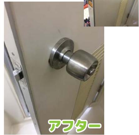
約37年お使用の浴室の扉で、一度もドアノブを交換したことが無かった為、浴室の湿気がドアノブ内部の金属を腐食させ、簡単に取はずすことが出来ず、電動工具を使用し力技で取り外しましたが、なんとか無事に交換する事が出来ました。作業時間：約1時間 目安費用：約1万円
